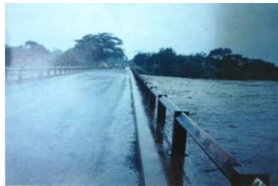
Foto 2-2.5 Aguas de inundación en puente Paso Real (Huracán Mitch)
