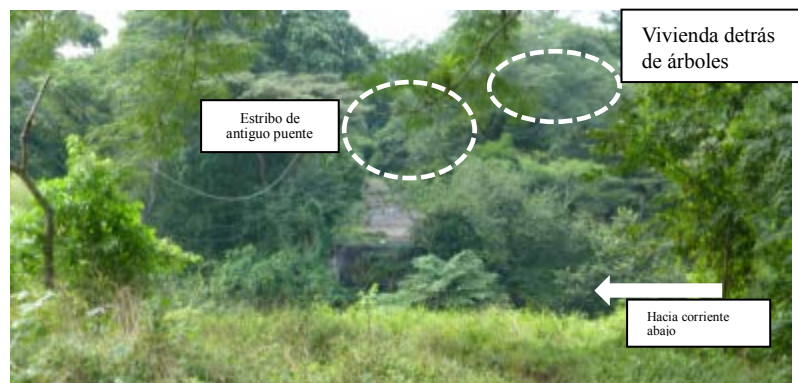
Foto 2-2.6 Cercanías del estribo de antiguo puente Paso Real (noviembre de 2013)
