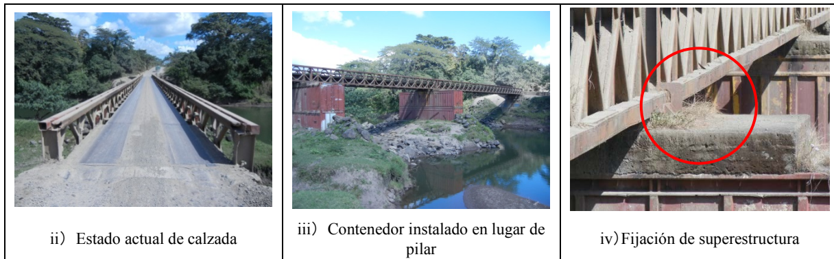
Foto 2-2.10 Puente Provisional en Servicio
