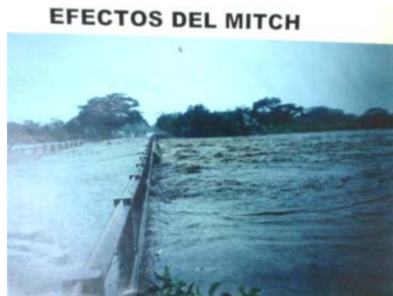
Foto 2-2.3 Aguas de inundación en puente Paso Real (Huracán Mitch)
