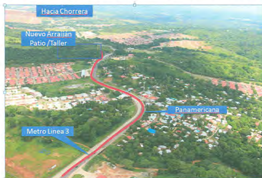
Figura 5-15. Vista Aérea del Área donde se Localizará el Patio/Taller
