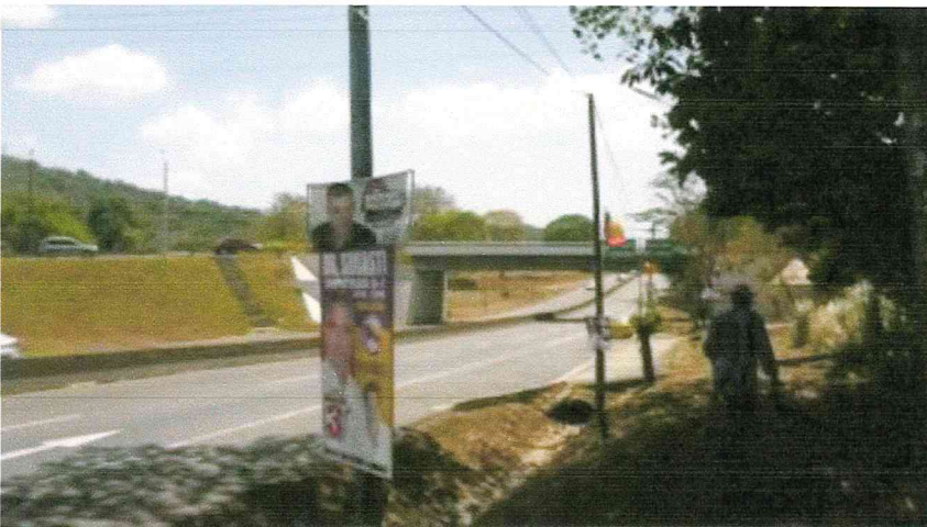
LOMA COBA - Costado Norte y Sur respectivamente
