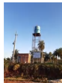
Sistema de Agua Virgen del Camino
