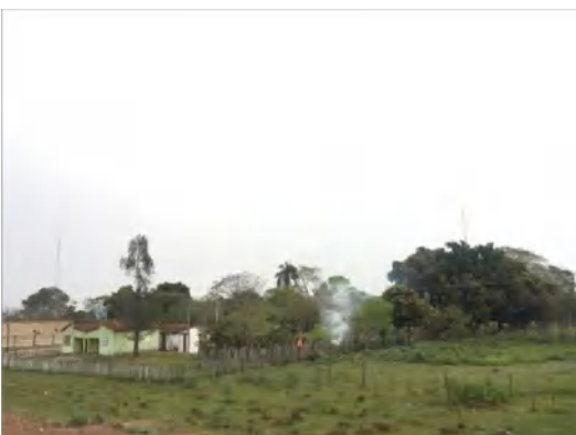
Disposición final de Residuos- Calle 15 Fuente: Registro fotográfico de trabajo de campo. Equipo consultor. Concepción. Agosto -Septiembre 2020.
