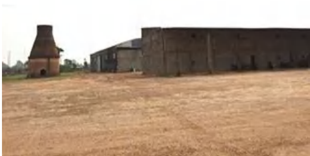
Horno para incineración de basura - Fuente: Registro fotográfico de trabajo de campo. Equipo Consultor. Concepción. Agosto -septiembre 2020.
