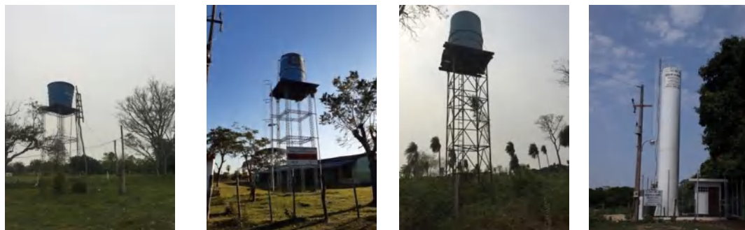
Water System, Santísima Trinidad, Loreto
