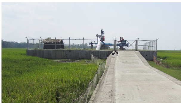
LNG Pipeline Facility
