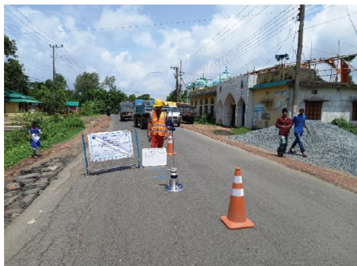
図 9.1.15 (写真)小型 FWD 試験実施状況
