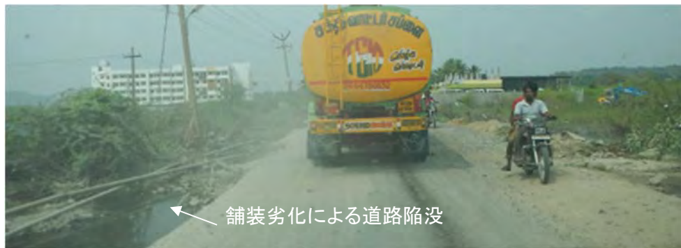
図 2.2.18 舗装の劣化による道路陥没
