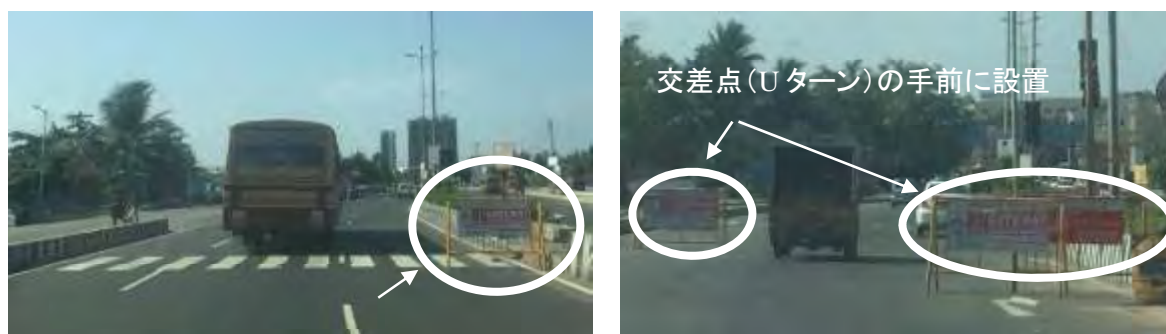
図 2.2.3 バリケードの設置
