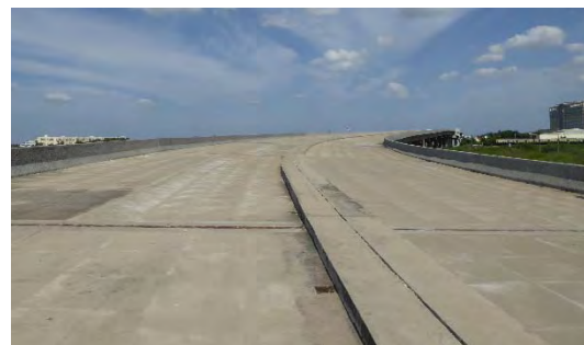
図 6.3.13 MJB101 と区間 4 終点施工済み橋梁(コンクリート舗装)
