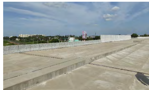
図 6.2.39 区間 4 終点施工済み橋梁(コンクリート舗装)
