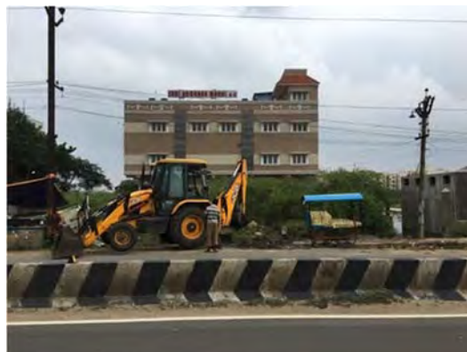
側溝の土砂排除作業
