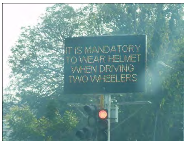
図 2.2.27 可変情報板及び表示メッセージ
