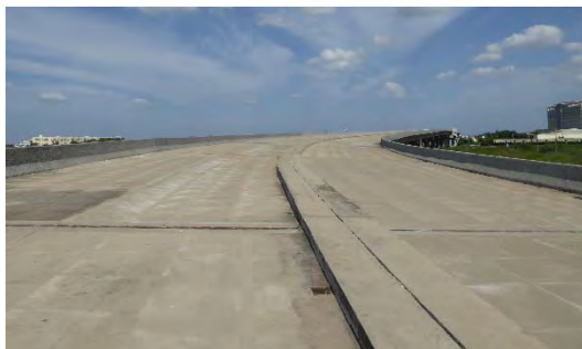
図 6.2.39 区間 4 終点施工済み橋梁(コンクリート舗装)
