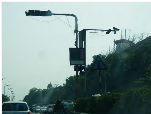
図 2.2.26 交差点における既存の交通信号及び CCTV カメラ
