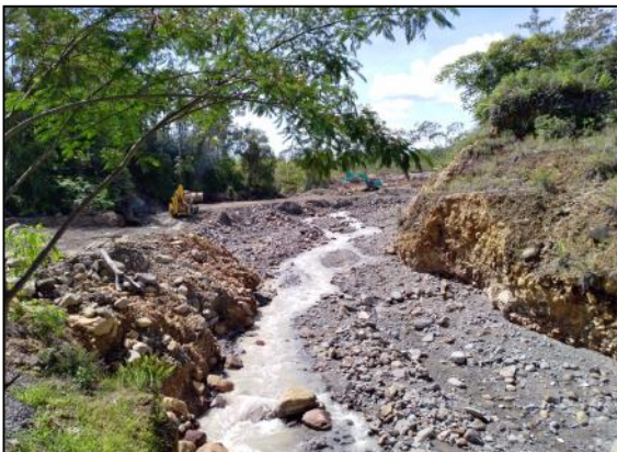
Gambar 5. Sungai yang berdekatan dengan lokasi PLTP Hululais
