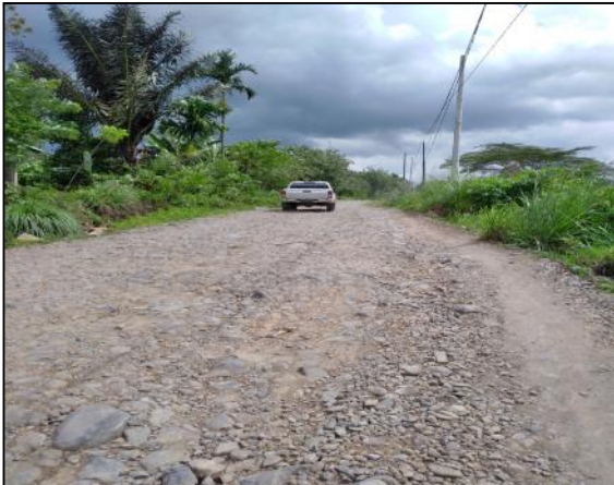
Gambar 3. Kondisi jalan menuju lokasi PLTP Hululais
