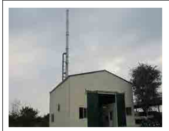
焼却炉の建屋 (ハイフォン都市環境公社工場敷地内)
