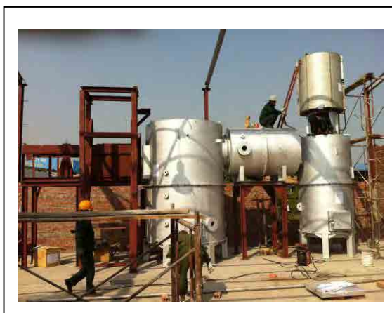
医療(感染性)廃棄物処理用焼却炉現地施工 (ハイフォン都市環境公社工場敷地内)
