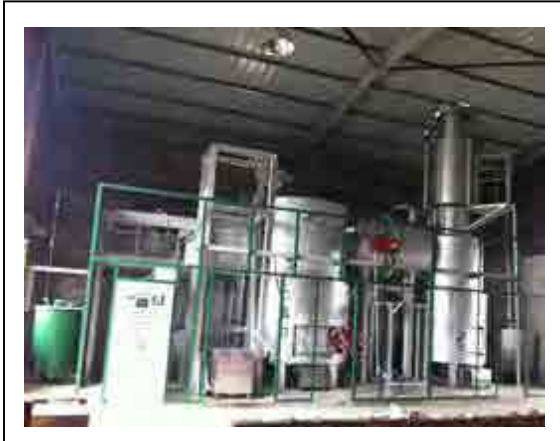
医療(感染性)廃棄物処理用焼却炉完成写真 (ハイフォン都市環境公社工場敷地内)
