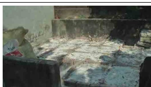
焼却炉に隣接する、焼却灰の固化施設
