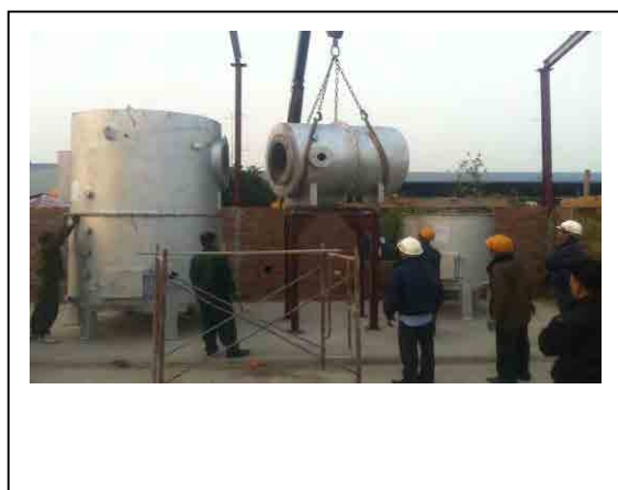
医療(感染性)廃棄物処理用焼却炉現地施工 (ハイフォン都市環境公社工場敷地内)
