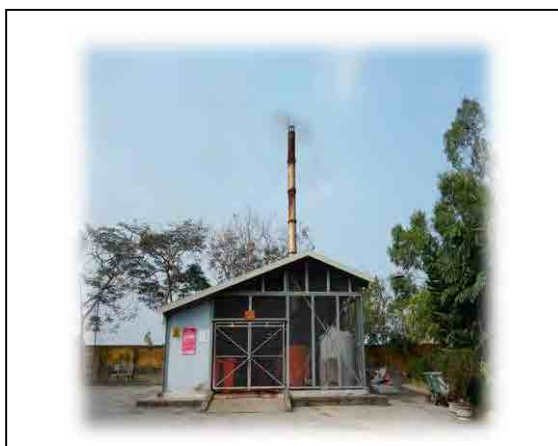
2014年1月まで使用されていた焼却炉 (ハイフォン都市環境公社工場敷地内)
