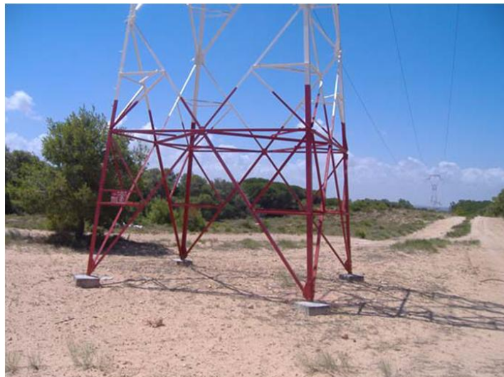
Figure 152 : Massifs réalisés pour supporter le pylône
