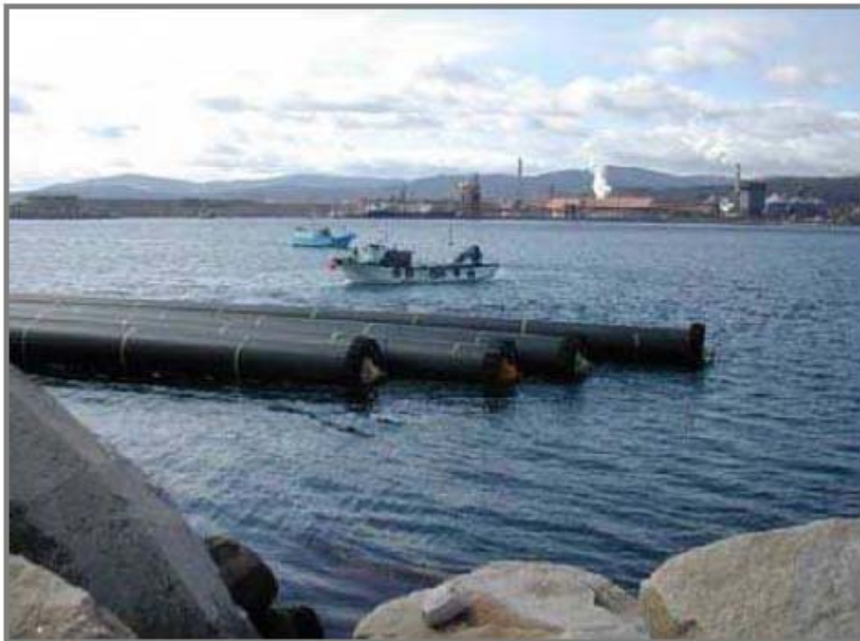
Figure 146 : Mode de stockage des conduites dans une zone abritée
