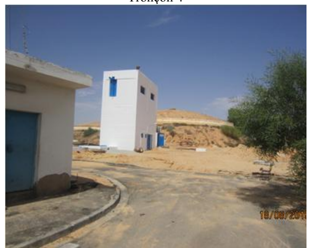
Site réservoir Sidi salah
