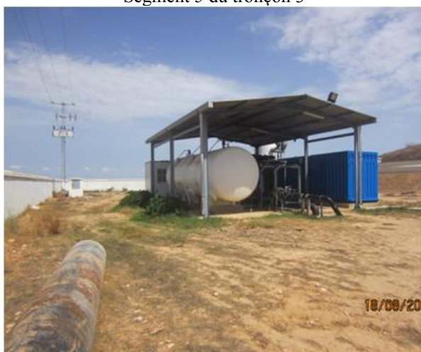
Site réservoir Sidi salah
