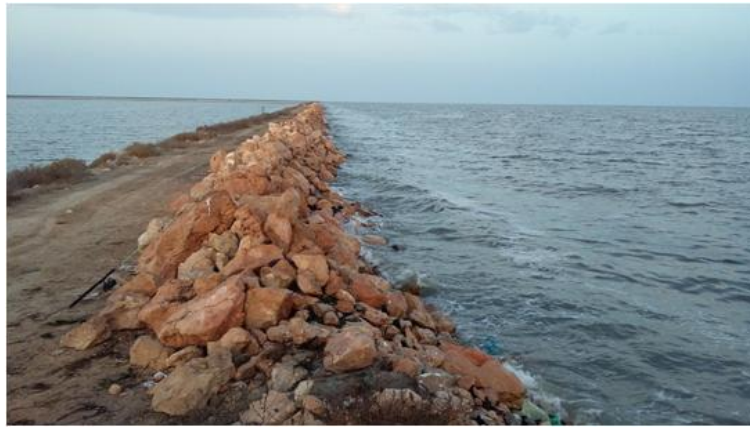
Figure 59 : Tronçon de côte protégé par des enrochements au veau des salines de Sfax sud
