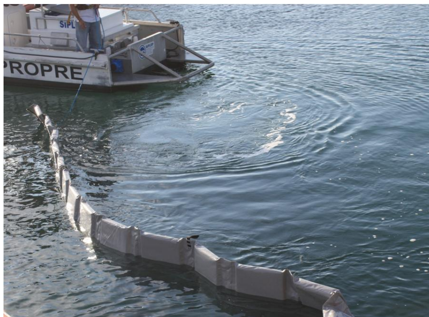
Figure 164 : Exemple d'écrans anti-turbidité pouvant être utilisé durant les travaux maritimes
