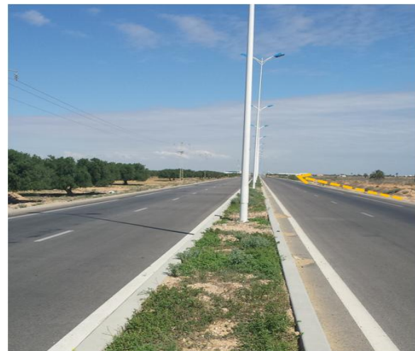
PK0,2 Km : Route nationale RN1 Sfax-Mahres au niveau du premier tronçon
