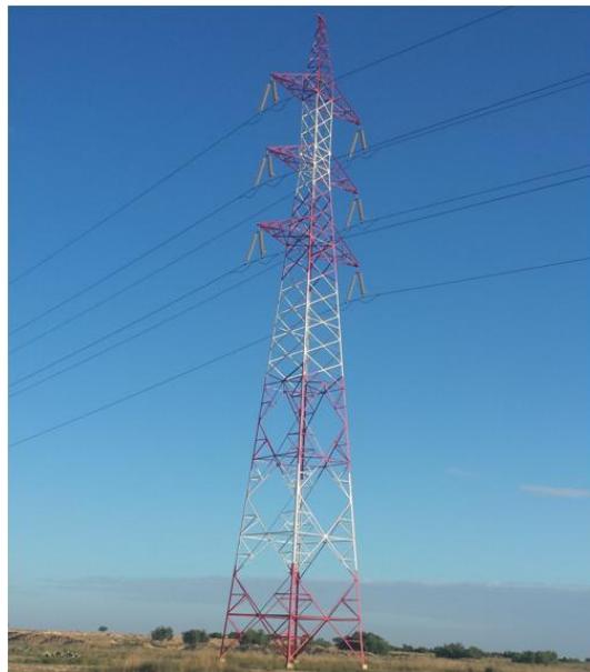
Figure 151 : Pylône type six triangles de la ligne HT Thyna-Sfax nord
