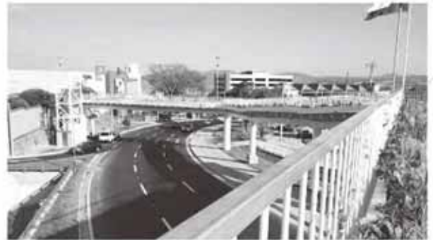
レンドン・マスフェラー歩道橋、サン・サルバドル。
