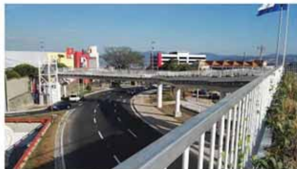
レンドン・マスフェラー歩道橋、サン・サルバドル。
