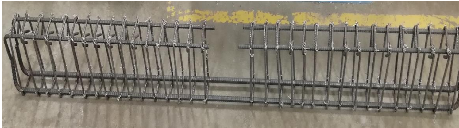
Fig: Rebar framework
