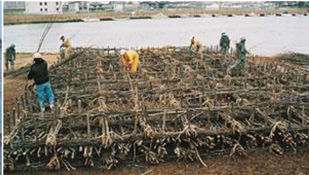
Fascine Mattress (erosion control)
