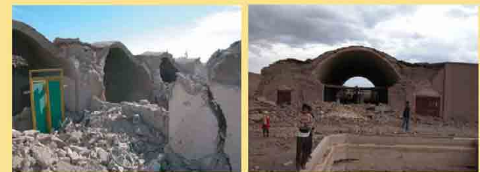
倒壊した日干しレンガ造のアドベ Collapsed 'Adobe' made of Sun-dried Bricks
