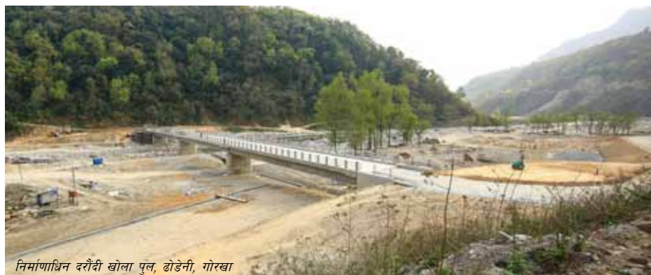
निर्माणाधिन दरौदी खोला पुल, ढोडेनी, गोरखा
