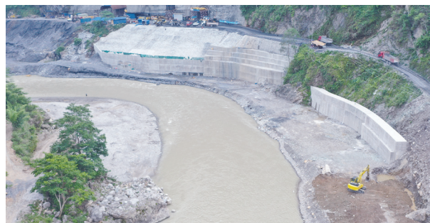
निर्माणाधीन तनहुँ हाइड्रोपावर आयोजना
