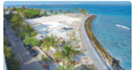
Un revestimiento costero en la Isla de Malé construido para reducir los daños producidos por los tsunamis (Maldivas)
