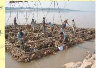
Trabajo de instalación de "Sodachisho"
