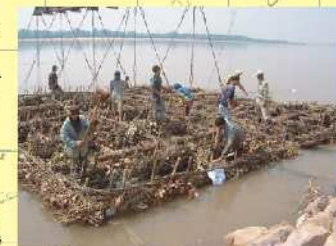
Travaux de mise en place des lits plongés avec des branches d'arbre
