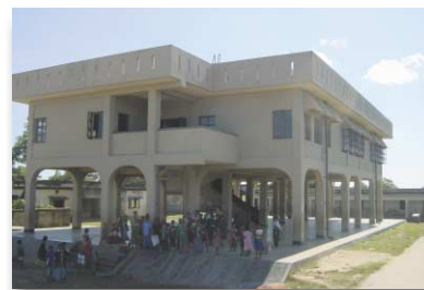
Bangladesh : Projet de construction d'abris polyvalents contre les cyclones (V)
