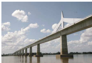
Laos et Thaïlande : Projet de construction du second pont international sur le Mékong
