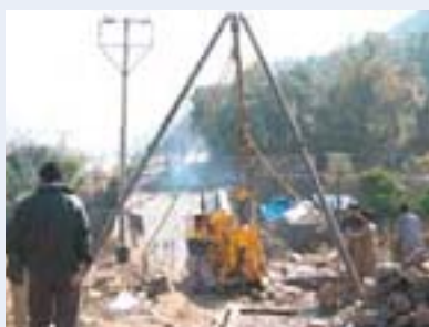
Sondage exploratoire pour la reconstruction d'un pont
