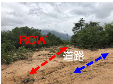
⑥60kV送電線ROW 土壌侵食対策が必要な例
