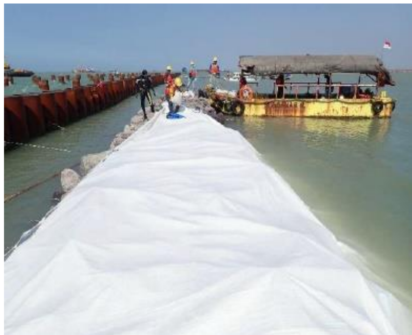
埋め立て工法の試験における汚濁 拡散防止策（シートの敷設）
