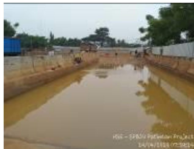
工事車両タイヤの洗浄場所
