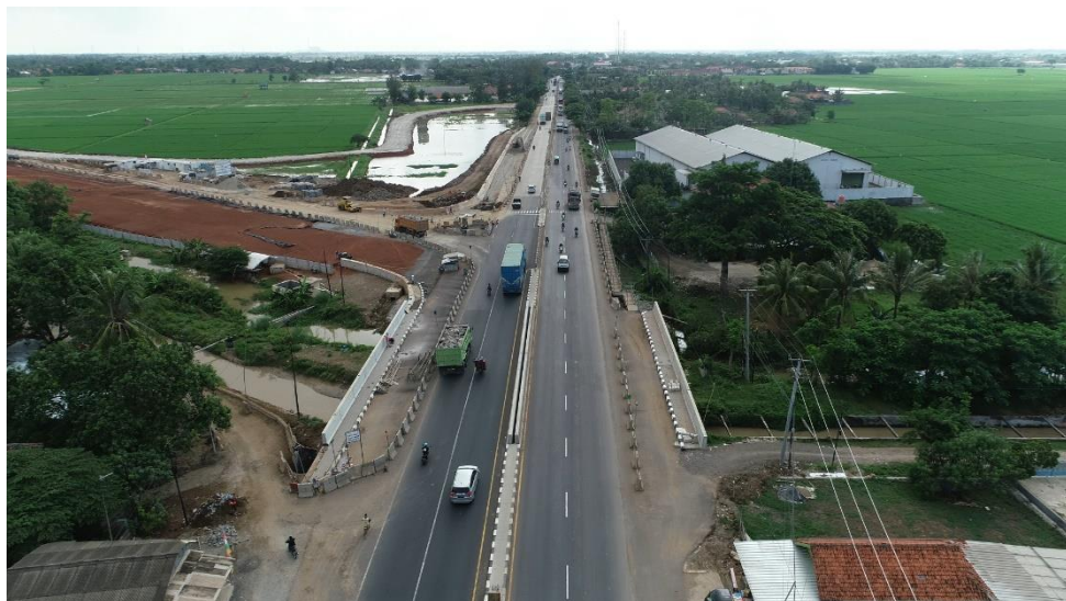
国道の状況（STA 0+000付近）
