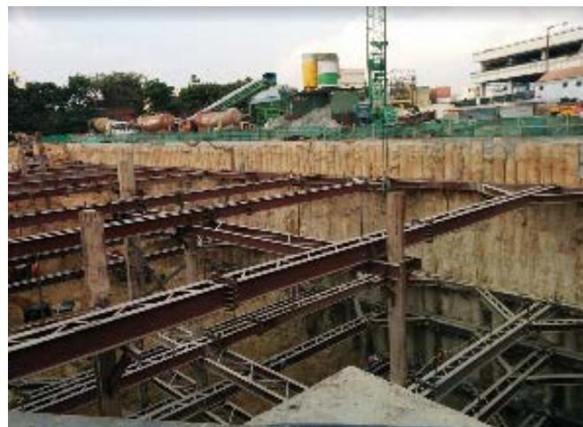
写真2：6号線（既往フェーズ）地下工事現場
