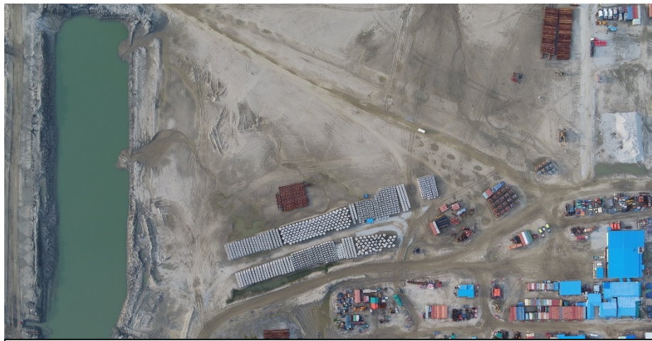
3/4号発電設備建設予定地（2020年9月撮影） （予定地上空よりドローン撮影）
