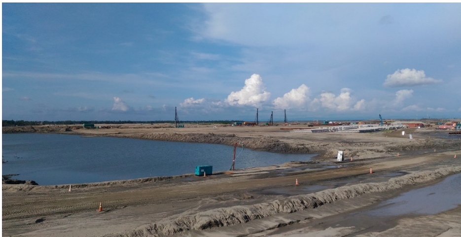
3/4号発電設備建設予定地（2020年9月撮影） （予定地南西より北東方向を向いて撮影）
