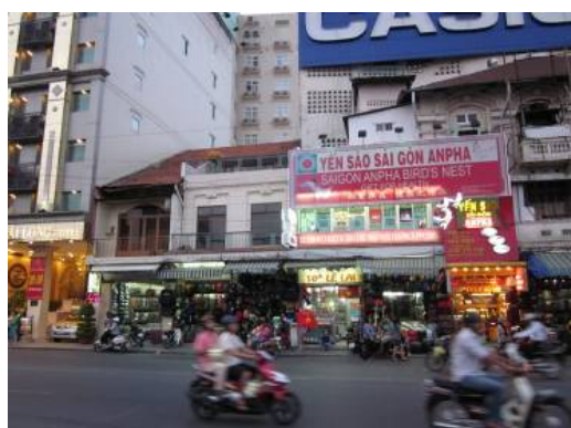
商業店舗が多く並ぶが歩道が狭く安全に利用しづらい
