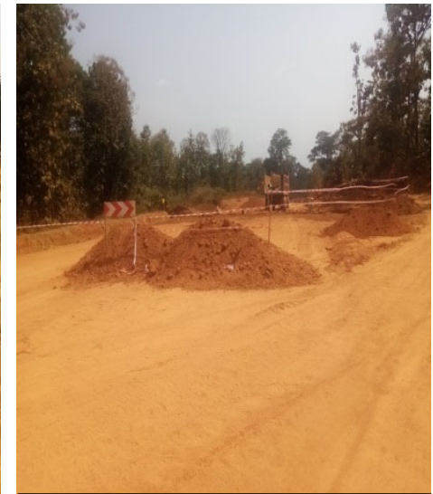
工事中であることを示す②
