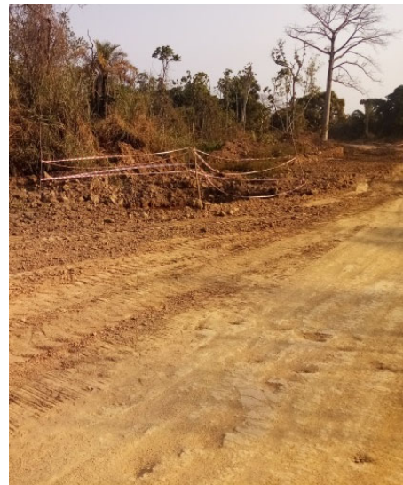
工事中であることを示す①
