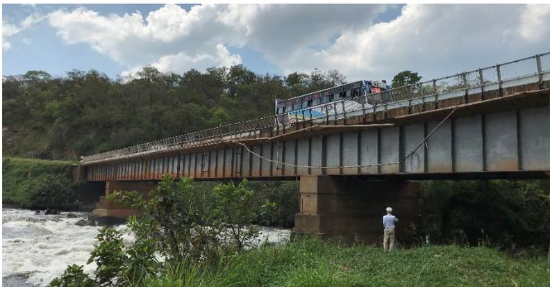
鋼桁の腐食、添架物の破損が目視で確認できる
