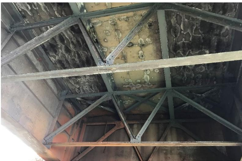
桁の内側から、床版の劣化と鋼材の腐食が確認できる
