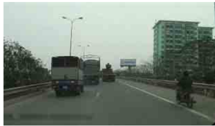
PVCG道路起点部
