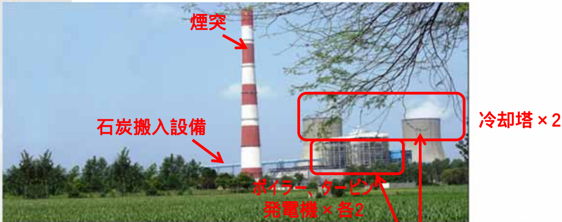
図4:既存発電所外観
