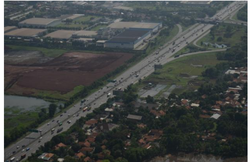
(ジャカルターチカンペック高速道路)
