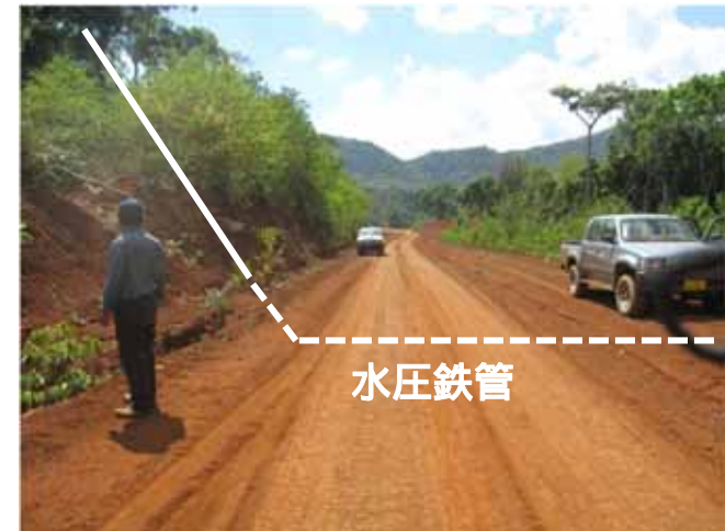
水圧鉄管路付近現況
