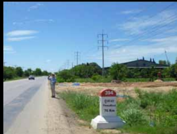
国道に並走するタイからの送電線
