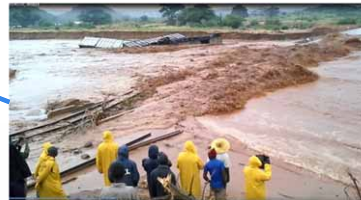
グルウェ駅手前の橋梁で、軌道・貨物列車の流出 →2日間の運行停止（2014年）
