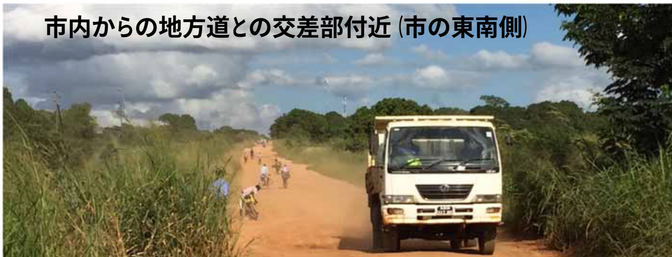
N1との接続部付近 (東側)
