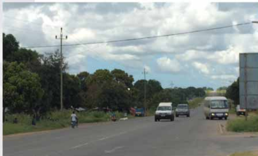
現道のナカラ市内手前の交通状況
