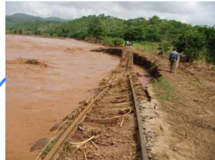
キロサ〜グルウェ間の32カ所で、軌道流出・橋梁崩壊 →6ヶ月間の運行停止（2010年）
