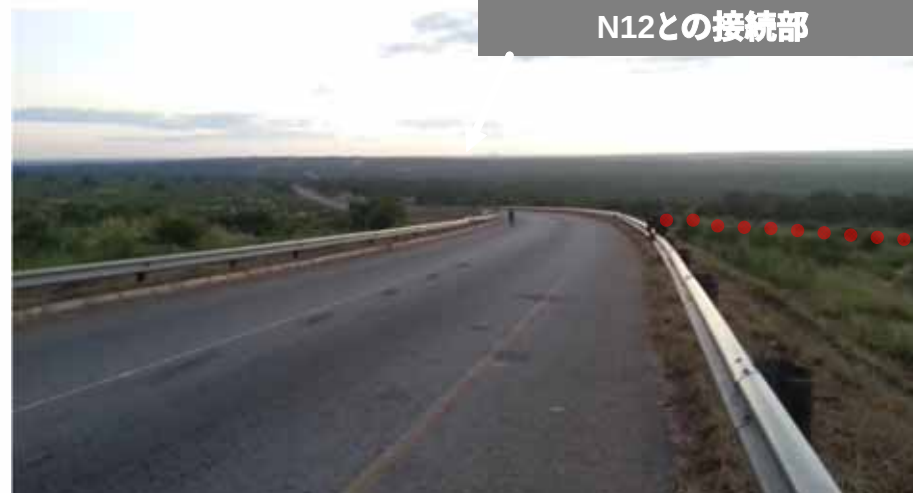
現道との接続部付近
