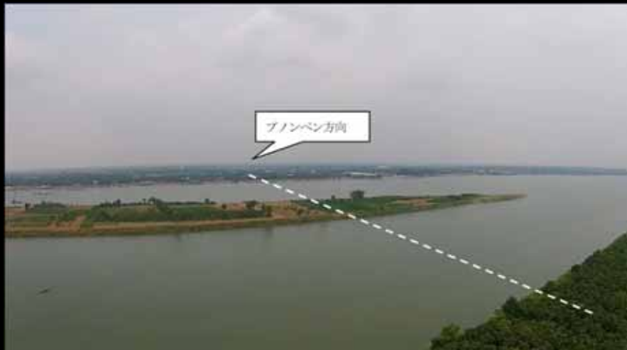
環状道路3号線のメコン渡河地点（長大橋建設予定地点）： 中洲の北側に橋脚を設置
