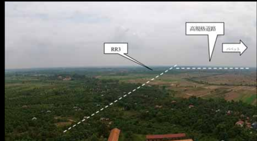
環状道路3号線のメコン渡河地点からプレイ・ベン方面を望む
