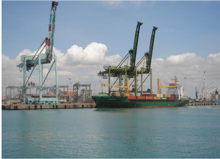
①コンテナターミナルの様子
