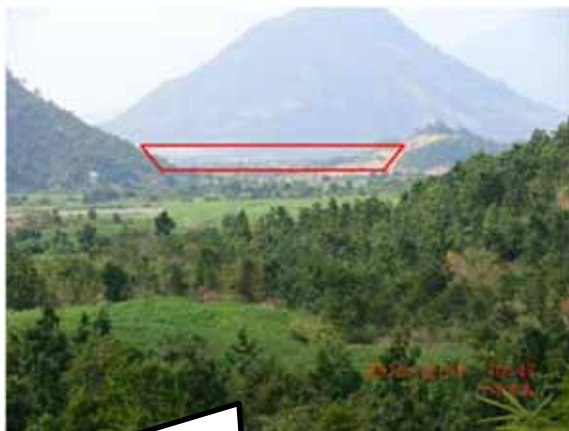
下部調整池地点遠景
