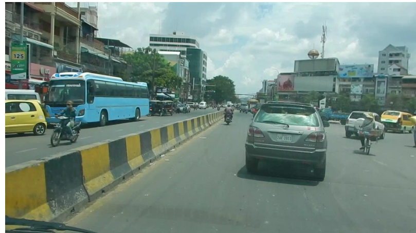
マオ・ツ・トン通との交差部
