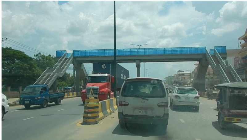
国道4号線、歩道橋
