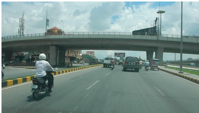
高架道路。AGTは高架道路の上を超える予定
