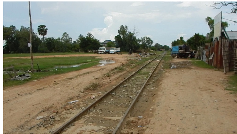
線路左側がサムラオ車両基地
