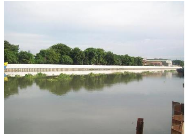
フェーズ2施工後のパッシング川上流側右岸： 美しく整備された護岸は河川の景観保護にも貢献
