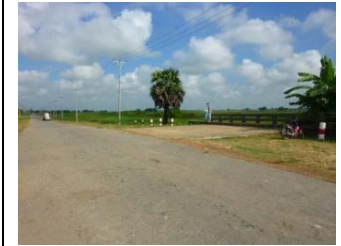
③現道上 BOX カルバート
