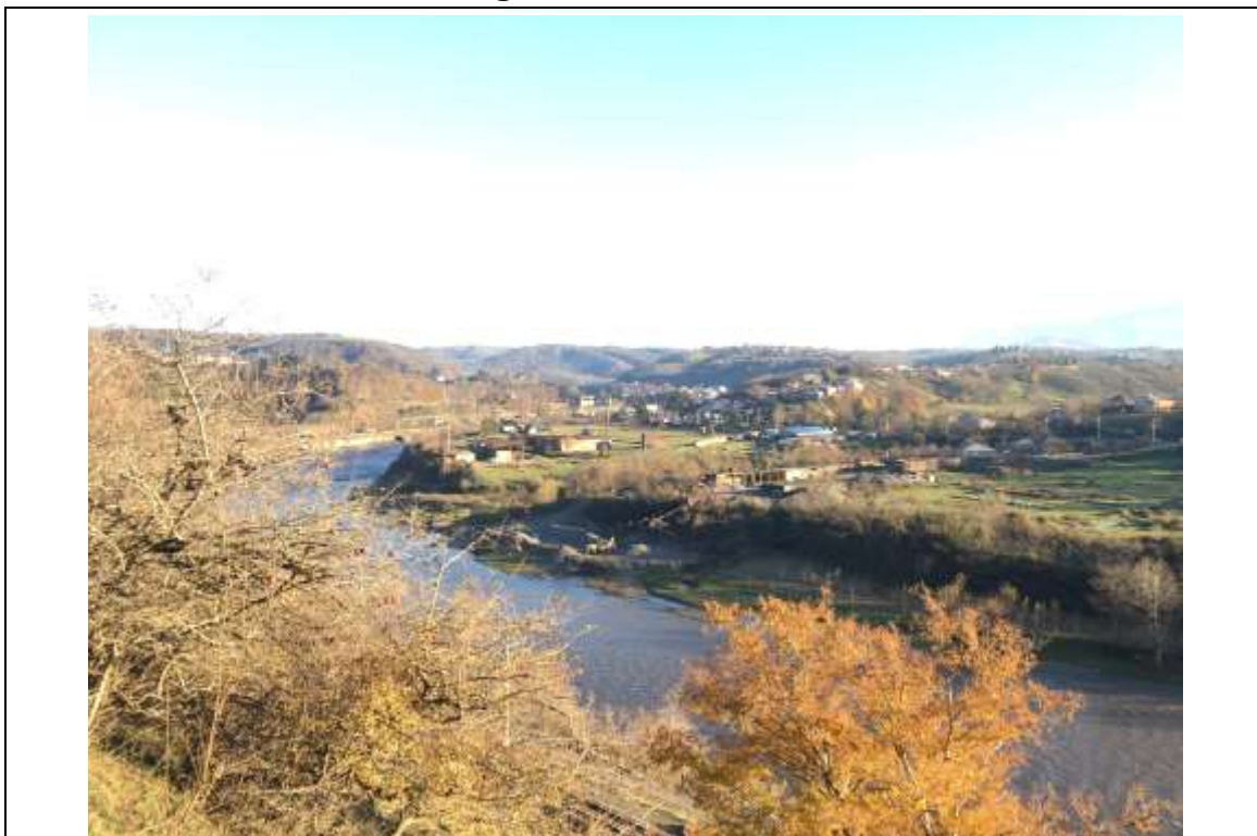
写真 1 : Bridge 4 北側から南側を望む (渡河位置は写真右手)
