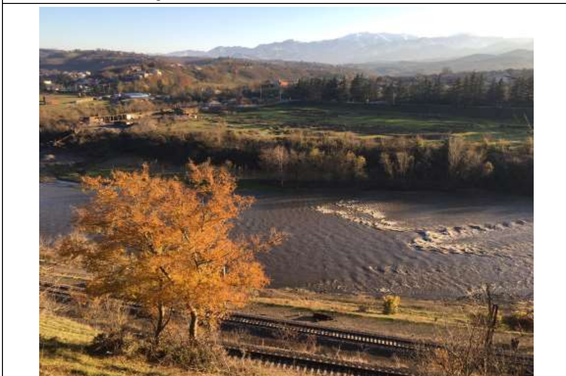
写真 2 : Bridge 4 北側から南側を望む (渡河位置は写真左手～中央辺り)
