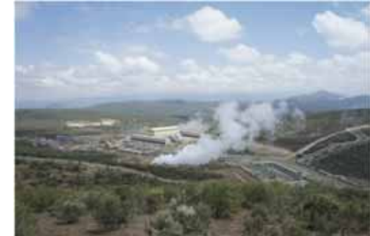
2014年内完成予定の オルカリアIV (140MW)の様子
