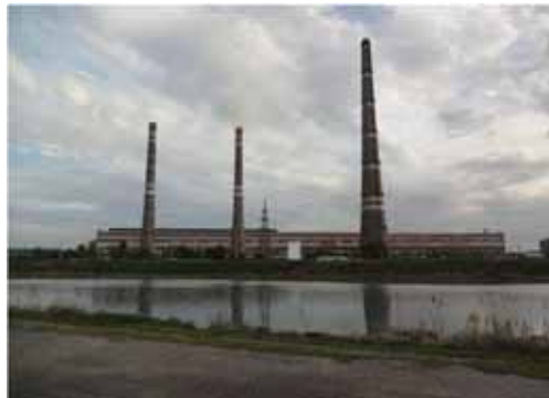
シルダリア火力発電所全景
