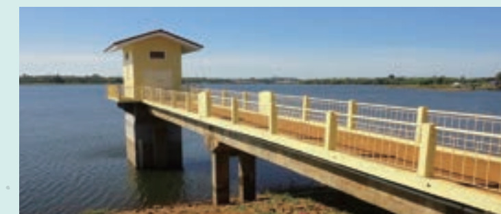
オチュム第一ダム取水塔
