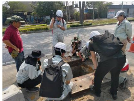
現地：管路調査の様子
