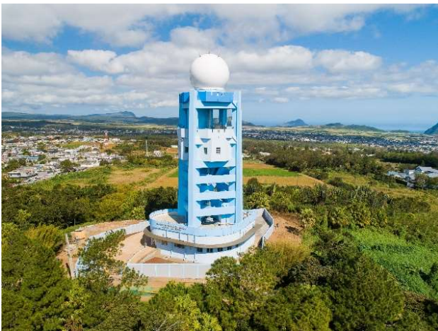
Mise en place d'un système d'observation météorologique efficace à Maurice.
