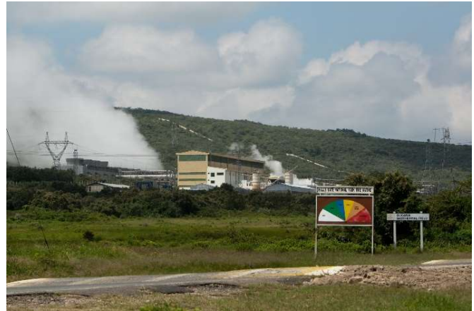
Développer l'énergie géothermique dans la zone d'Olkaria (Kenya) en vue de répondre à la demande d'électricité grâce à des sources d'énergie renouvelables.
