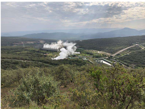
La centrale géothermique d'Olkaria, située à 100 kilomètres au nord-ouest de Nairobi au Kenya, utilise des turbines à vapeur fabriquées au Japon.
