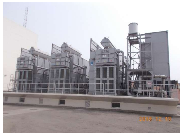
Au Ghana, la JICA soutient la modernisation d'une sous-station pour stabiliser l'approvisionnement électrique.
