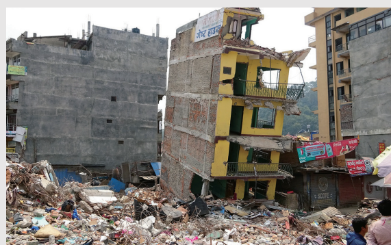
Domages occasionnés par le séisme de 2015 au Népal.
