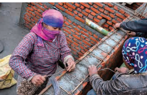
Après le tremblement de terre au Népal en 2015, la JICA a fourni une aide à la reconstruction des maisons selon le concept « Reconstruire mieux » en soutenant la réalisation de bâtiments résistants aux séismes avec les communautés locales. (Népal)
