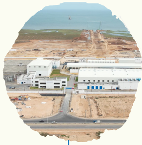
دخول محطة تحلية مياه البحر بصفاقس حيز الاستغلال
