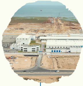
دخول محطة تحلية مياه البحر بصفاقس حيز الاستغلال
