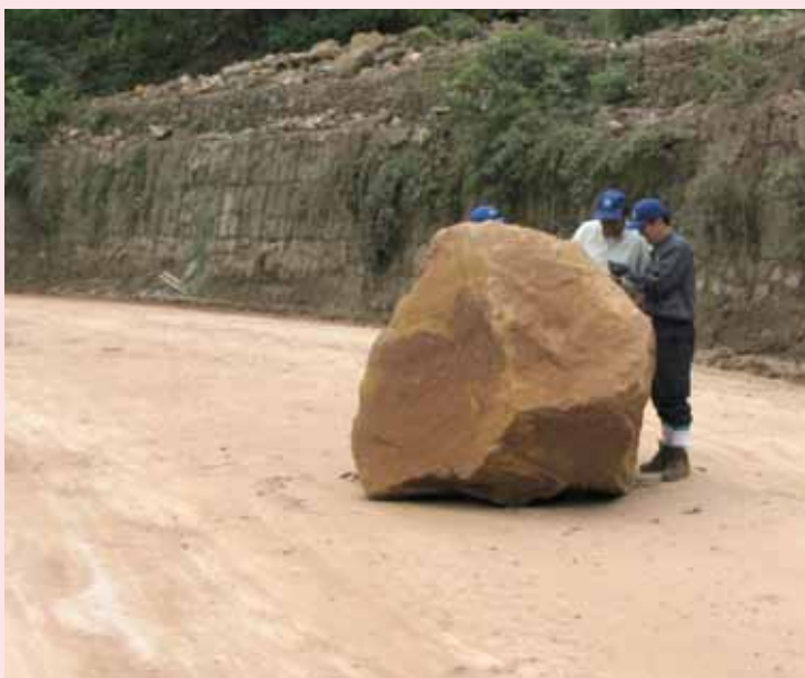
Examen des blocs d'éboulement (taille, scénario d'éboulement, dégâts)
