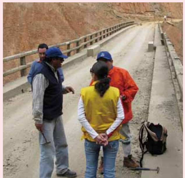
Discussion dans le cadre de l'enquête réalisée sur l'état du pont
